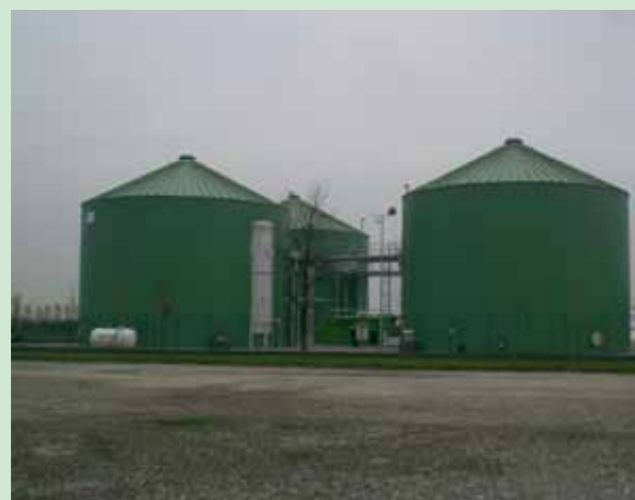
Altro impianto biogas realizzato in Lombardia (digestori)
