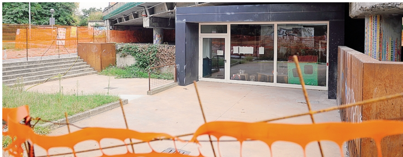
Anche la "casa del quartiere" sotto il cavalcavia è stata resa inaccessibile per motivi di sicurezza per tutta la durata dei lavori Ribolini
